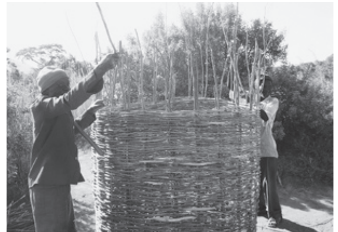
トウモロコシの貯蔵庫をつくるズールーとピリ：木の枝を集めてきて、上手に編みあげていく。
